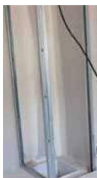
Réalisation et fixation de la structure de la gaine
