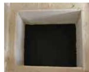
Isolation et étanchéité de la trémie au droit du placher de l'étage (coté étage)
