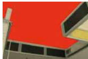
Cas maïson à étage ou collectif : mise en oeuvre isolant en sous face supérieure du plénum (polystyrène extrudé 25mm, classement feu M1)
