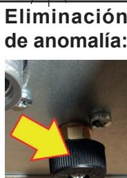
**Eliminación de anomalía:** Restaure el valor correcto de presión interviniendo en el grifo de carga de la caldera (para un funcionamiento óptimo dicho valor debe estar comprendido entre 0,8 y 1 bar). Al alcanzar el valor de presión mínimo (0,6 bar), se restaura el funcionamiento de la caldera.
