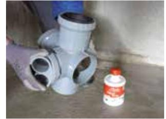
**4 - Enfoncer** sans attendre le module à fond d'emboîture. L'angle pour la pente est réglable de 1 à 2,5°.
