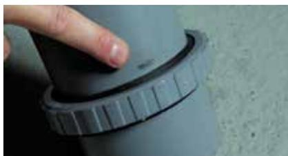
2 - Enfiler la bague de serrage du joint sur le tube sans dépasser le repère.
