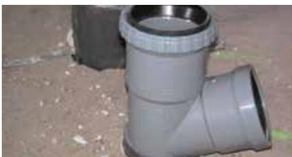
Désolidariser la chute au niveau de la traversée de plancher par un matériau résilient d'une épaisseur suffisante (5 mm environ).
