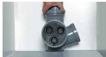
3 - Après collage de la culotte de l'étage supérieur, insérer le tube de descente dans la culotte de l'étage inférieur et serrer la bague.
