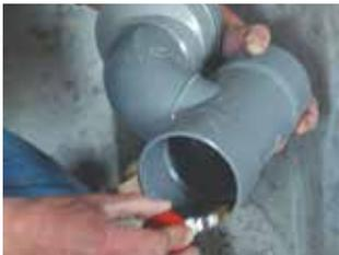
**1 - Coller la partie** basse de la culotte sur le tube de l'étage inférieur.
