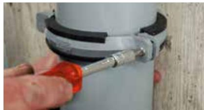
Après connexion aux culottes des niveaux supérieur et inférieur, serrer le collier de façon à constituer un point fixe.
