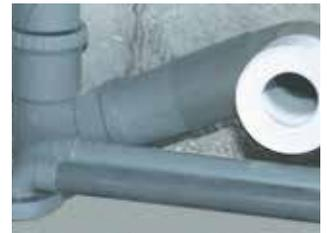
**4 - Retirer à l'aide d'une pince les opercules du tampon de réduction universel** utiles. Connecter les collecteurs sanitaires et le WC.
