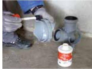
**3 - Dépolir, dégraisser et encoller** l'emboîture du module.
