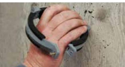
Fixer 1 collier acoustique type COAAT ou COAT par tige d'étage. Sur mur maçonné, fixer ce collier à 20 cm du plafond, sous la bride acoustique. Si la gaine est constituée de 4 cloisons légères, fixer le collier sur une équerre fixée au plafond et non sur les cloisons légères.
