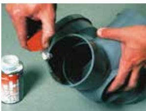
1 - Coller la culotte sur le tube de l'étage inférieur.
