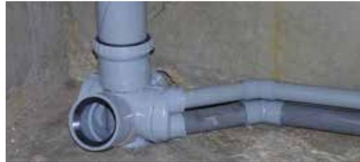
**7 - Pour les collecteurs Ø 40mm, insérer une réduction incorporée IJ** entre l'emboîture femelle Ø50 du module et le tube, ou un tampon souple désoperculable JAJ4. Si vous ne connectez qu'un collecteur, **condamner l'emboîture** restante avec un tampon PJ.
