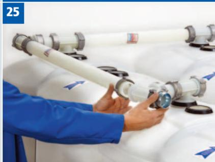
25) Connecter le remplissage de la rangée au T de remplissage avec filtre.
