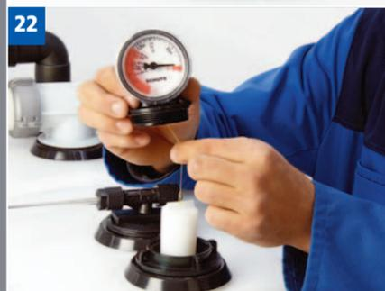
22) Dans l'orifice muni de l'adaptateur, laisser prudemment descendre le flotteur de la jauge et ensuite visser l'ensemble. Pivoter l'écran de la jauge pour l'adapter au contenu du réservoir.
